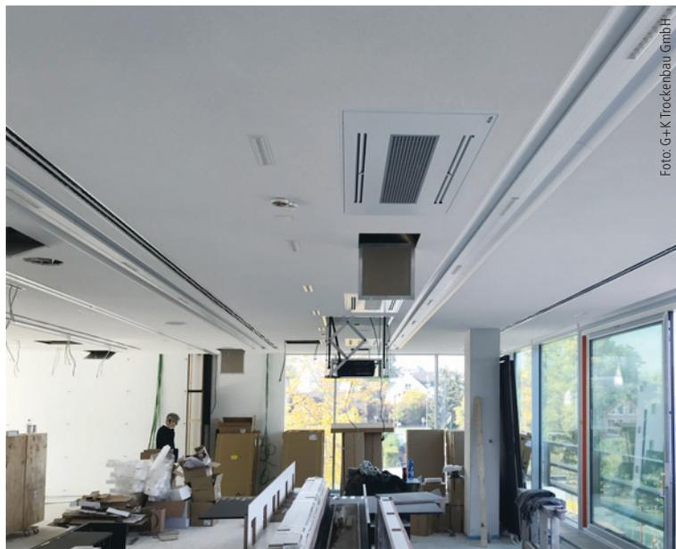
Versorgungseinheit Decke. Zahlreiche Einbauteile, darunter durchaus großformatige, galt es in die Unterdecke zu integrieren. Das bedeutete viel Präzision im Detail.
