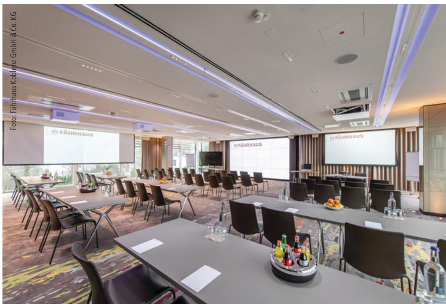
*Weit gedehnt. Da Lüftungs- und Leuchtenbänder immer wieder für eine Unterteilung der Decke sorgen, war die sorgfältige Anlage von Dehnfugen an den Verbindungsstellen der einzelnen Deckenfelder unerlässlich.*
