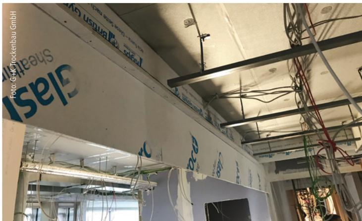
Dicht machen. Im Spa-Bereich erfolgte die Lüftung teilweise über den Deckenhohlraum. Luftdichte Abschottungen mit Sonderdübeln wurden hier montiert. Jeder Dübel, der die Dampfbremse durchdringt, musste sorgfältig wieder abgedichtet werden.
